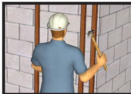
En el caso de utilizar martillo no debe introducirlos completamente en la Fachada Tek, deje fuera la cabeza y parte del cuerpo unos 4 mm, luego la embute. De esta manera evita dejar marcas de martillo en la Fachada Tek.
