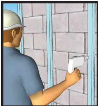
Instale el furring channel sobre la pared de concreto con tornillo @ 40.6 cm mínimo o 61 cm y expandir o clavo de impacto. Recuerde que cada furring channel debe estar aplomado. En las uniones verticales donde van dos clips es necesario colocar doble furring channel para colocar cada clip en uno de ellos.
