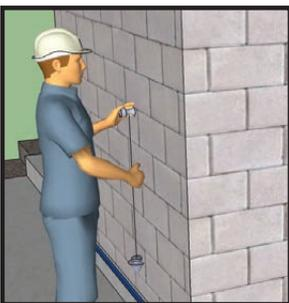
Antes de instalar sobre una pared de concreto el Plydekor, es necesario asegurarse que se encuentre la superficie aplomada y uniforme, para evitar deformaciones en el producto y alteración del acabado.
