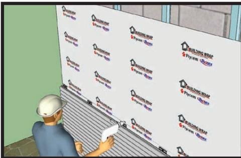
Instale el Plydekor sobre el furring channel con tornillo PH 8-175 o clavo de impacto. Recuerde colocar los tornillos según el esquema zig zag indicado en la página #3 de fijaciones.
