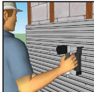
Fije las piezas de Plydekor a la estructura previamente instalada de madera con clavos de 2" utilizando martillo o clavadora.
